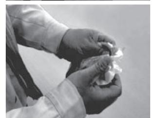
④GCキャップ先端部の段位置までJLファイラーを注入します。(GCキャップ28.6用で約50g)
