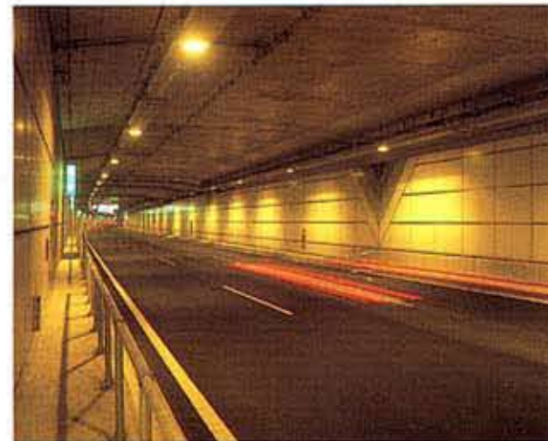
多摩川トンネル
